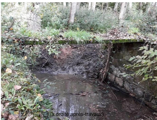
Figure 62 : Travaux d'effacement des vestiges du vannage du Boistissandeau sur le Petit Lay (avant / après)
