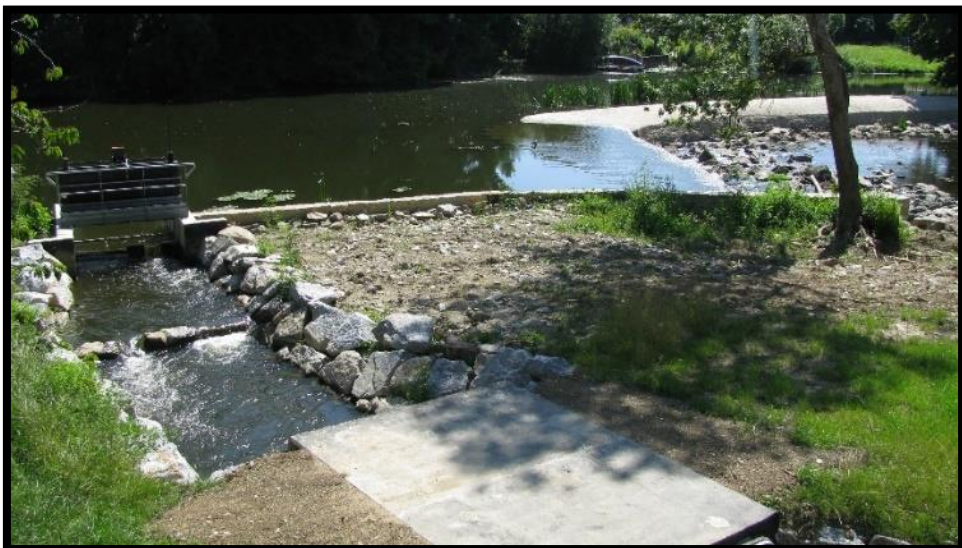
Figure 26 : Passe à poissons de la chaussée de Mareuil visitée pour la signature du CRBV 2017 - 2019
