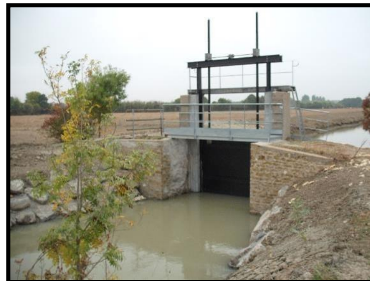
Figure 23 : Restauration de l'ouvrage de la Cale
