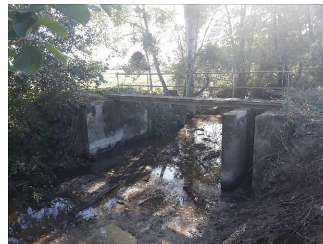
Figure 61 : Travaux d'effacement des vestiges du clapet de moulin Neuf sur le Petit Lay (avant et après travaux) :
