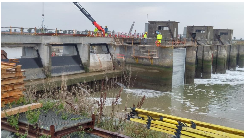
Figure 53 : Travaux du barrage du Braud en octobre 2017
