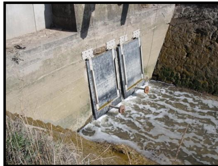
Figure 22 : Restauration du clapet des Grenouillets
