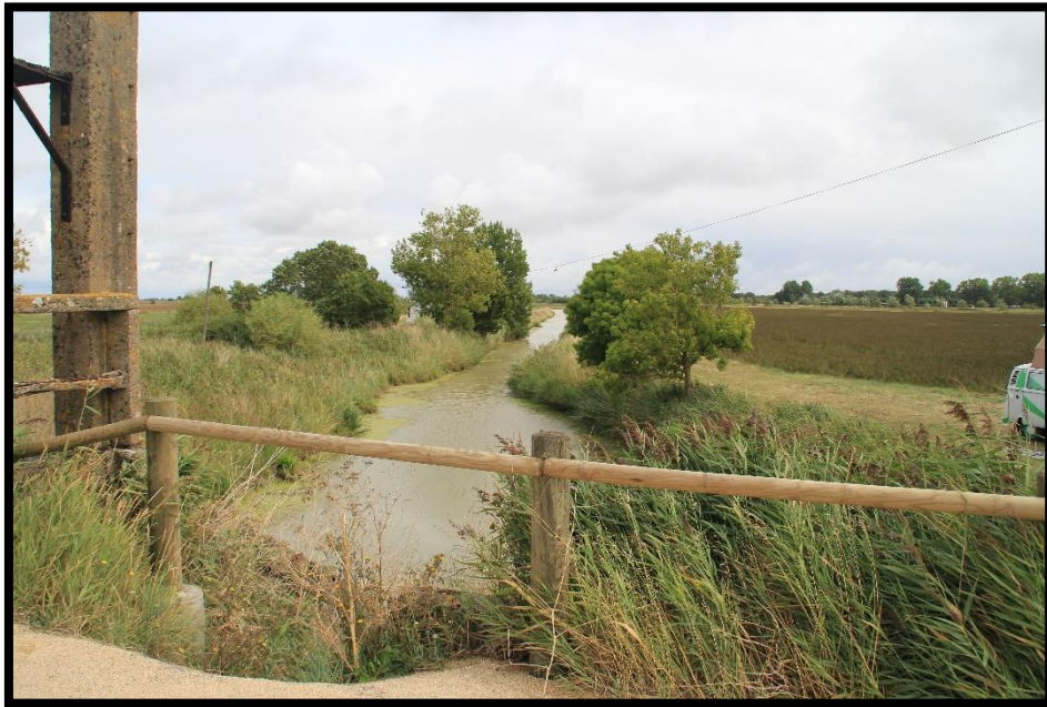
Figure 32 : Point de suivi du pont des Roullières sur le Canal de Ceinture
