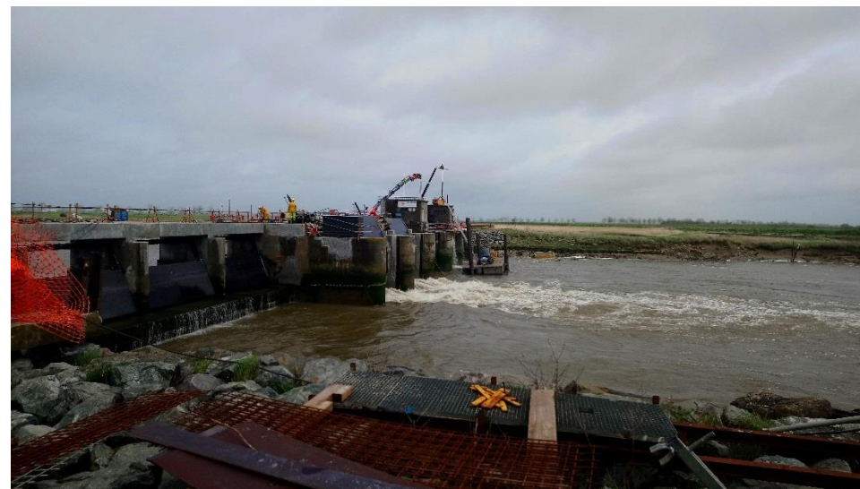
Figure 7 : chantier du barrage du BRAUD
