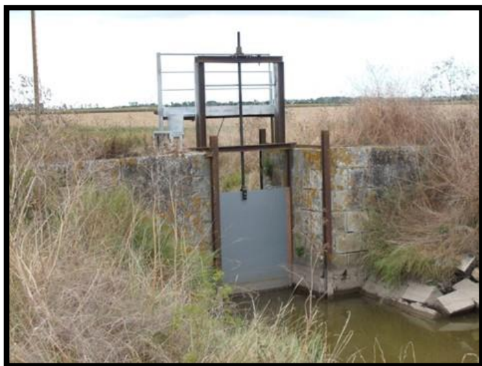
Figure 21 : Restauration de la vanne de la Bouillère
